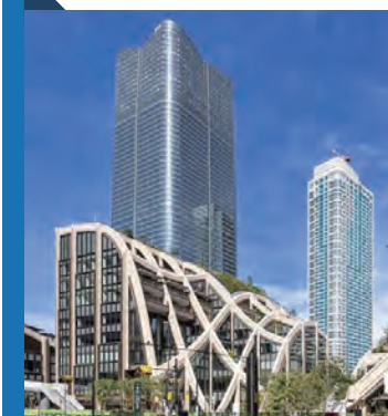
虎ノ門・麻布台地区再開発C街区 東京都港区
