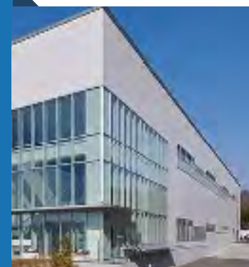
日新電子工業工場新築工事 東京都八王子市
